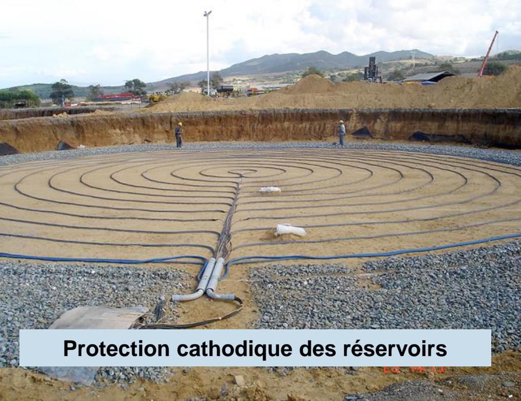
**Protection cathodique des réservoirs**
